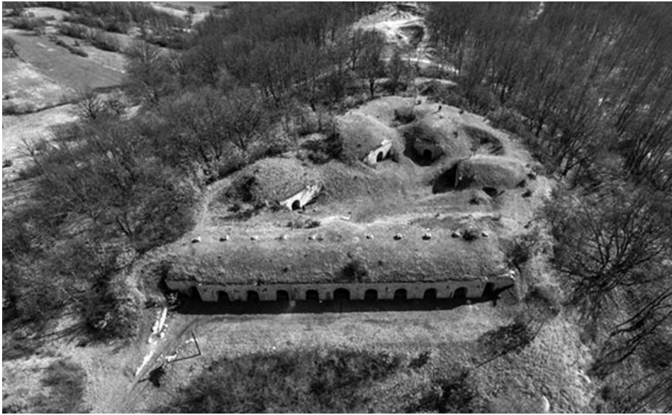
Слика 8. Одбрамбени бедем са казаматим и осигурани простор са магацинима (фото: А. Никишић, 2022)
